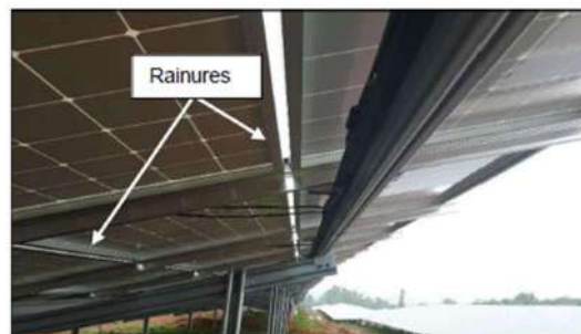
Figure 9 : Rainures par lesquelles s'écoule l'eau
